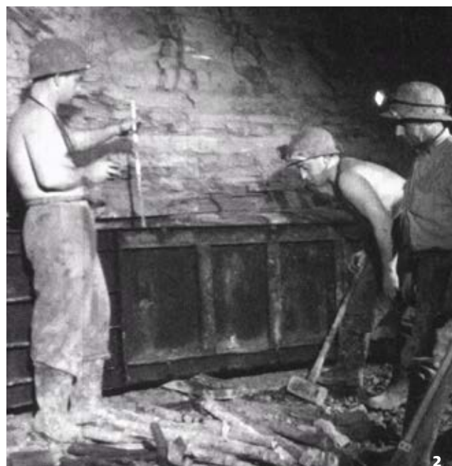
Fonçage du puits de Berrwiller (1958) © Collection Emmanuelle Bueb, MIRA
