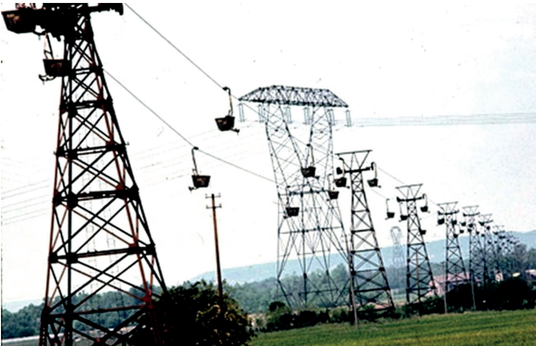
Transporteur aérien TP Max (1927- 1984) réservé au transport du calcaire de la carrière de Maxéville à la soudière de Dombasle.
