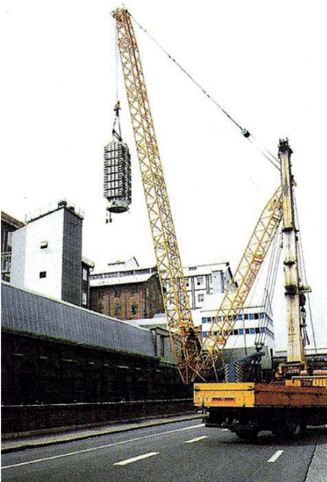
1998 remplacement d'une colonne de Carbonatation 154 tonnes H: 25 cm
