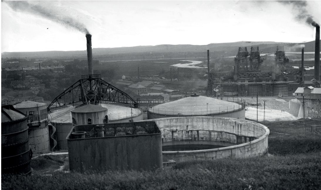
Bassins d'épuration calcium et magnésium des saumures en provenance des sondages de Haraucourt.
